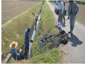
<水路の泥上げ、草刈り>
