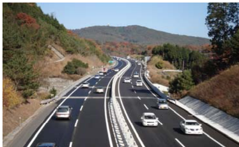
賀陽IC付近での4車線供用状況
