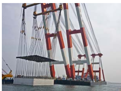
水深12m岸壁ケーソン設置状況
