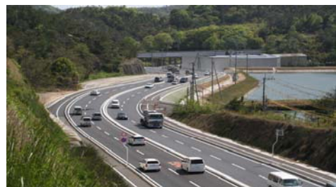
国道429号倉敷～総社間の4車線供用状況
