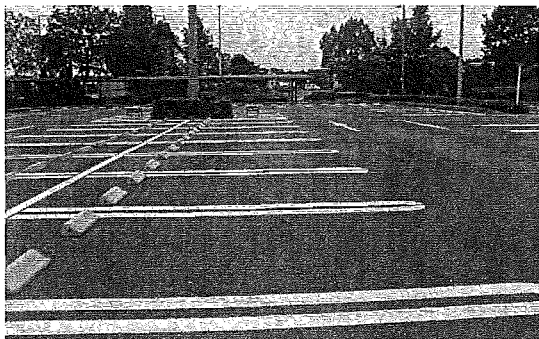
[駐車枠の状況]
