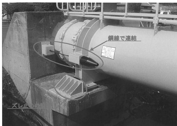
震災対策工事例：送水3号線水管橋
