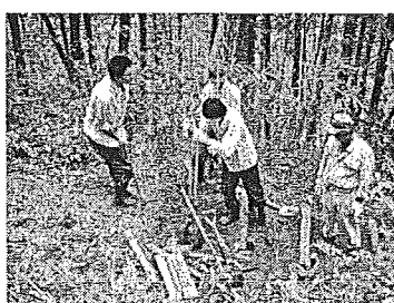
遊歩道の整備
